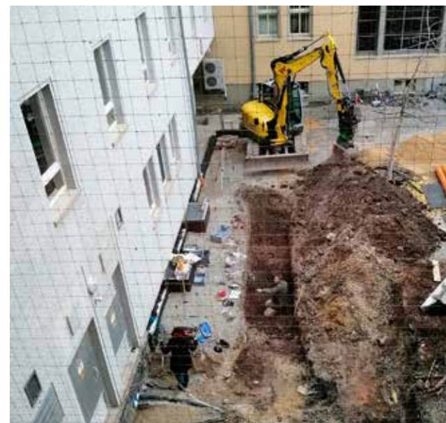
Abb. 29: Übersicht über das Baufeld im Dezember 2019 auf dem früheren Kirchplatz nördlich der Kollegienkirche. Innerhalb des Leitungsgrabens befanden sich die 8 dokumentierten Bestattungen.
