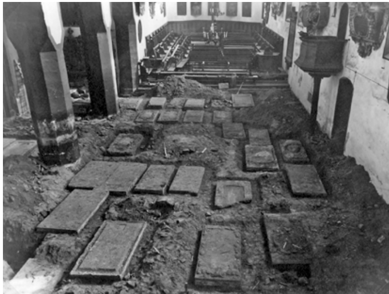
Abb. 24: Blick in das Schiff der Kollegienkirche während der Renovierungsarbeiten 1936. Im Vordergrund sind die freigelegten Grabplatten der Professoren gut erkennbar. Nach der Dokumentation wurden einige Platten an den Wänden der Kirche aufgestellt, die übrigen verblieben im Boden.
